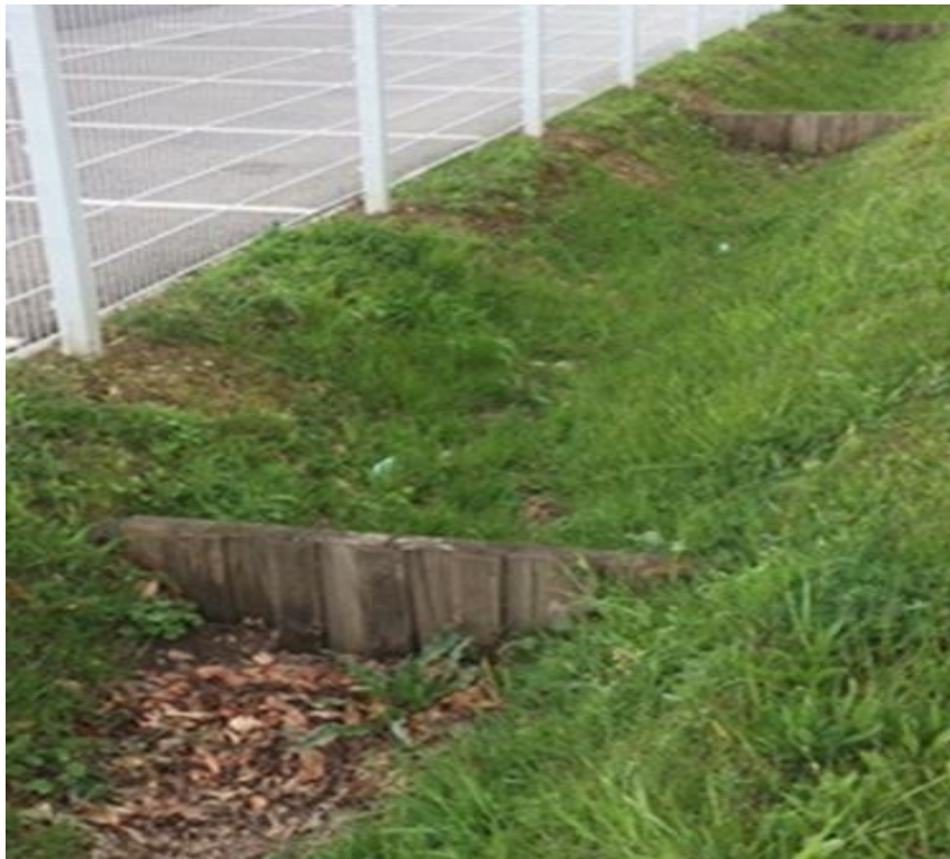
Noues de recueil des eaux pluviales le long des voies de circulation à proximité du projet
